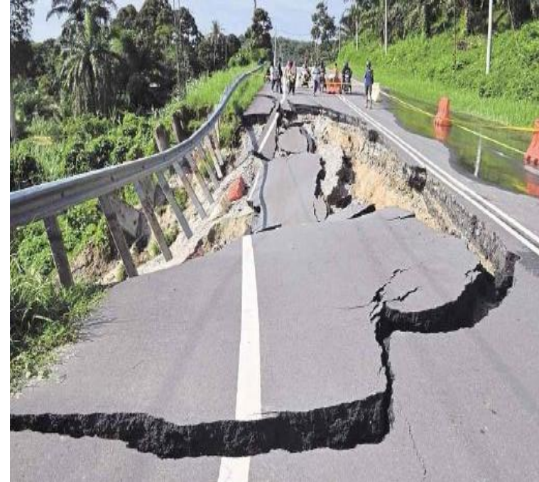
Slim River: Kebocoran paip air dan hujan lebat dipercayai menjadi punca sebahagian Jalan Kuala Slim di Batu 4 di sini runtuh dan terpaksa ditutup kepada lalu-lintas
