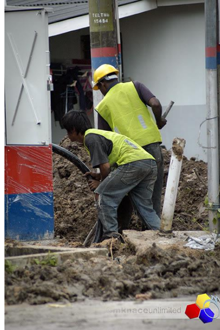
kerja-kerja membaikpulih Kabel voltan tinggi yang rosak di Jalan Wawasan , Ampang SELANGOR
